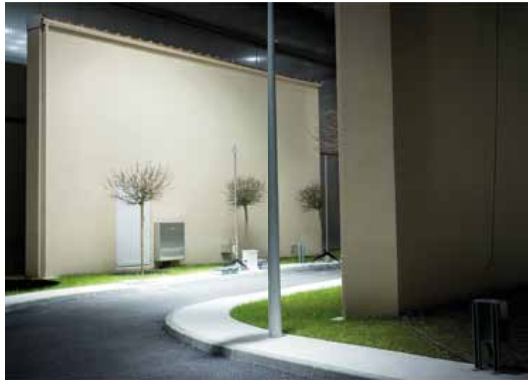
À Sense-City, une reconstitution de « rue canyon » permet d'étudier les échanges thermiques entre les murs et l'environnement extérieur.
